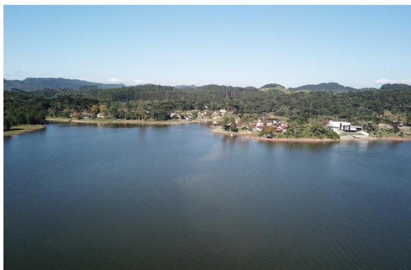
Figura 2 - Barragem Palmeiras em Rio dos Cedros/SC
