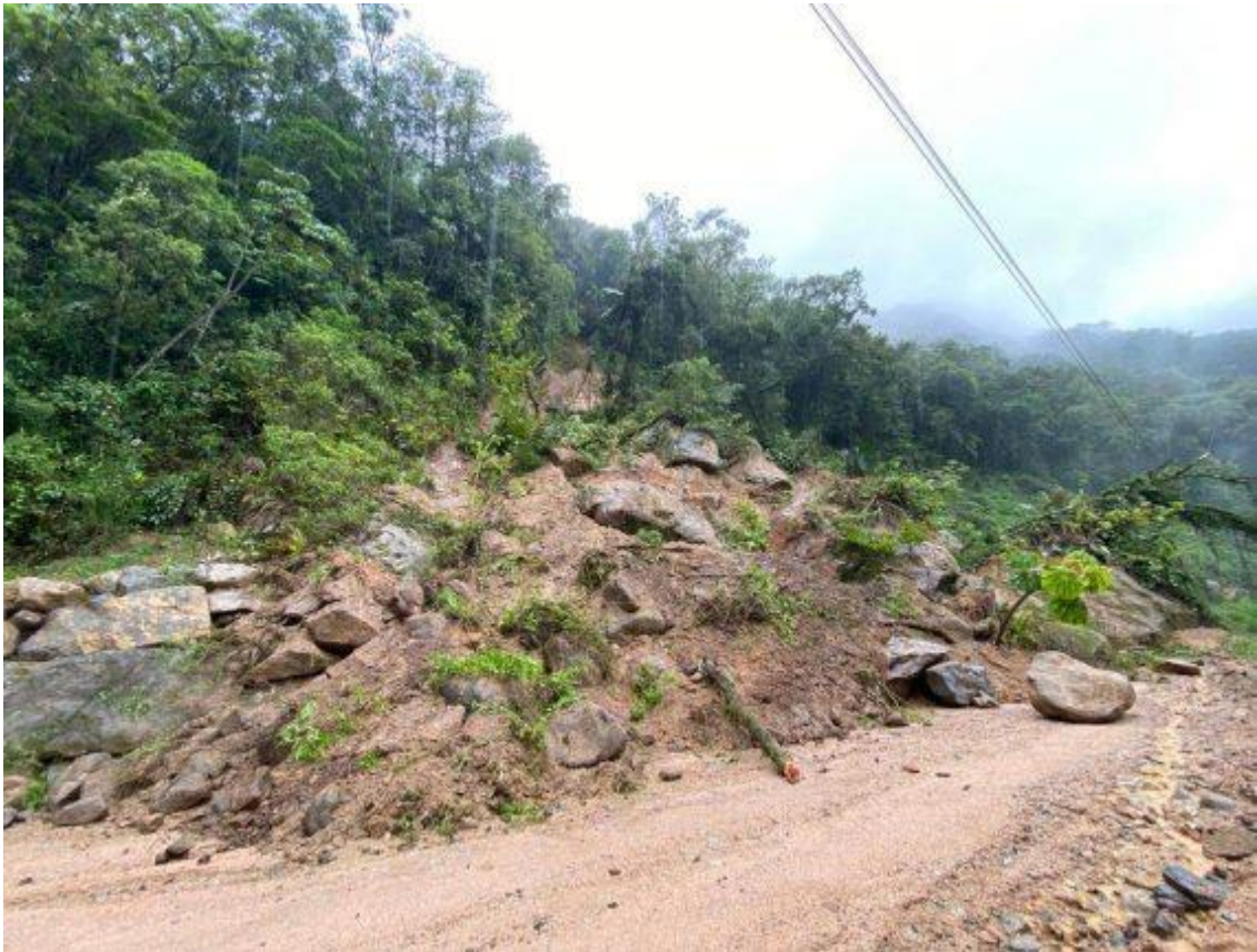
Figura 05: Deslizamento de Terra (2022)
