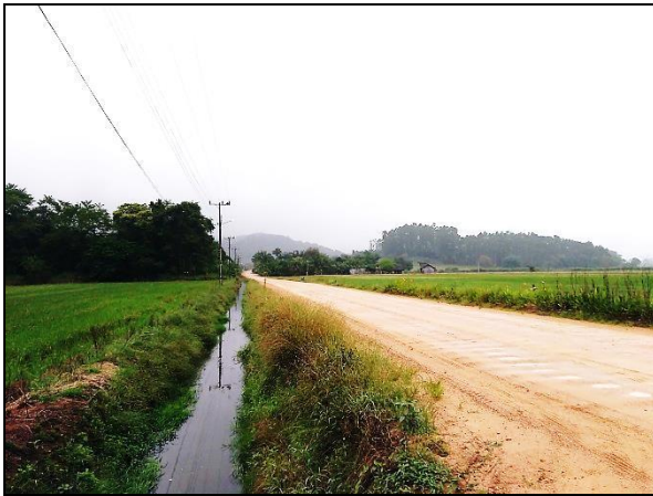
Figura 30 – Vala de drenagem da rizicultura paralelas a rodovia municipal.
