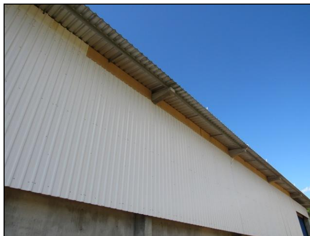
Figura 45 - Barreiras acústicas nas saídas livres da edificação do empreendimento - Barreiras verticais.
