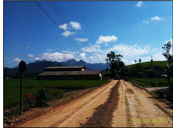
Figura 29 – Trecho não pavimentado da Rodovia Municipal RDC-110 próximo ao empreendimento.
