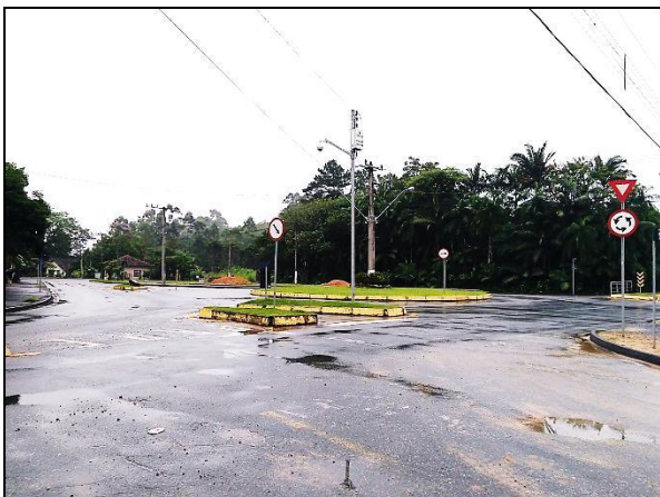
Figura 24 – Vista do acesso pavimentado à Rodovia Municipal RDC-110 (trevo entre a Rua Duque de Caxias e RDC-110).
