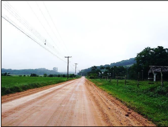
Figura 28 – Trecho não pavimentado da Rodovia Municipal RDC-110 próximo ao empreendimento.
