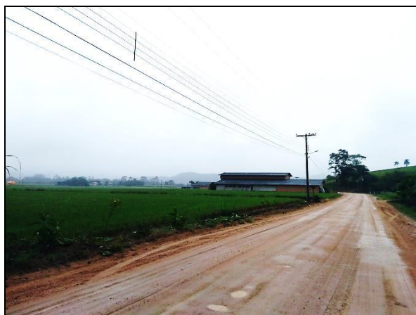
Figura 27 – Trecho não pavimentado da Rodovia Municipal RDC-110.
