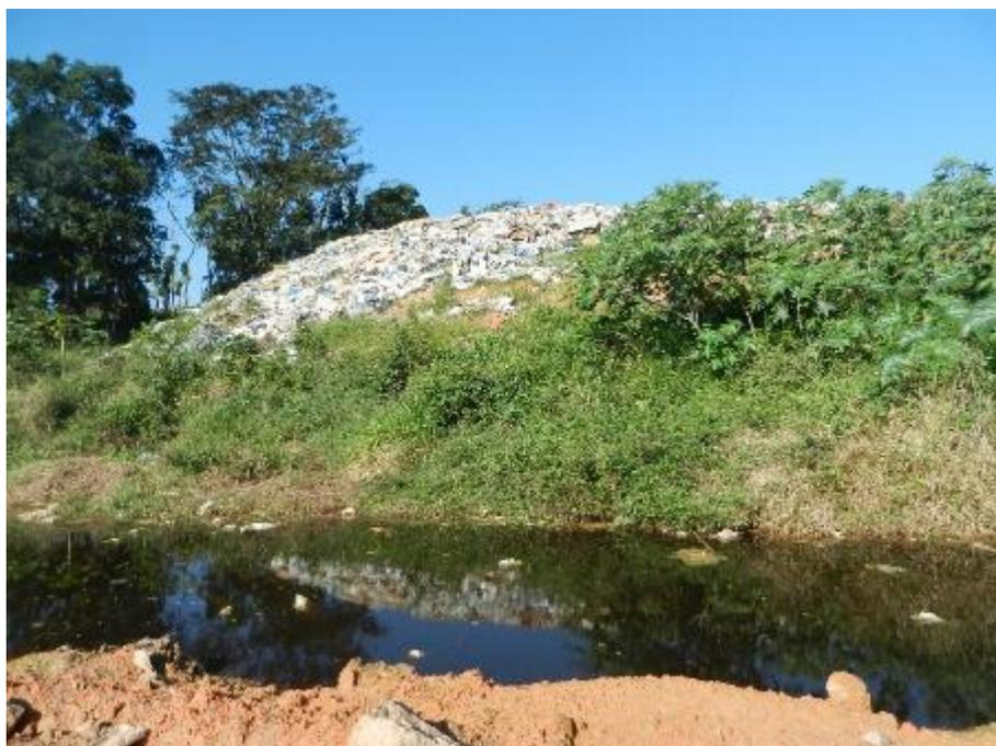
**Figura 6.33. Problemas de drenagem de chorume no aterro sanitário de Timbó.**
