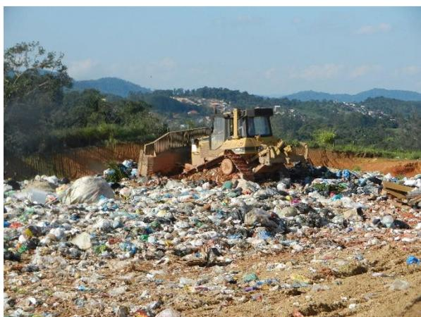
**Figura 5.97: Trator realizando a compactação dos resíduos no aterro**
