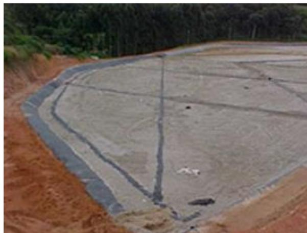
Figura 5.89: Vala séptica onde são aterrados os RSS descontaminados. Fonte: Recicle SC (2014)
