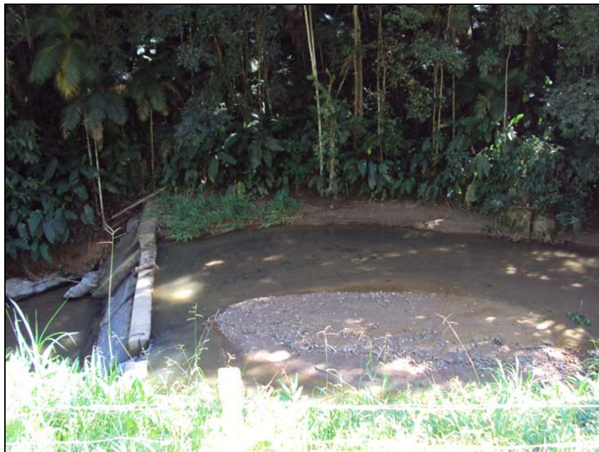
Figura 5 – Captação Principal Sistema Rio dos Cedros
