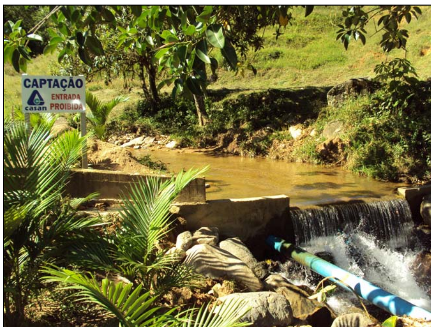
Figura 6 – Captação Sistema Rio dos Cedros (nascente)
