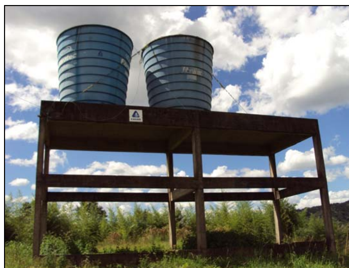
Figura 13 – Vista dos Reservatórios Sistema Alto Rio dos Cedros
