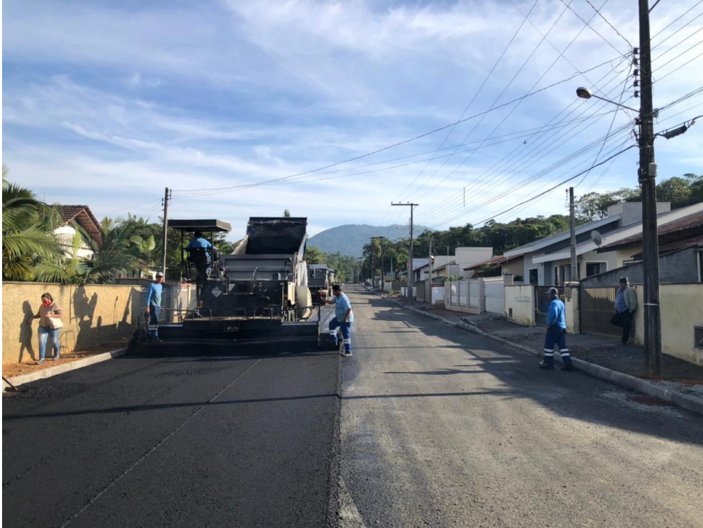
Figura 78 - Pavimentação asfáltica
