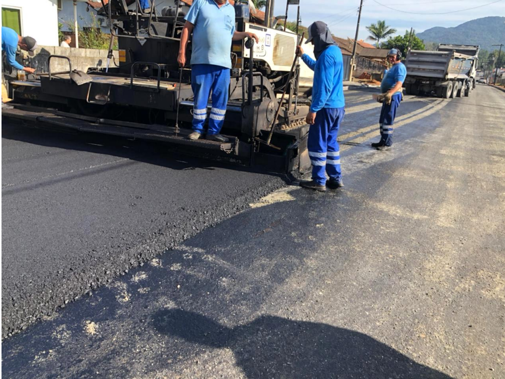
Figura 61 - Pavimentação asfáltica
