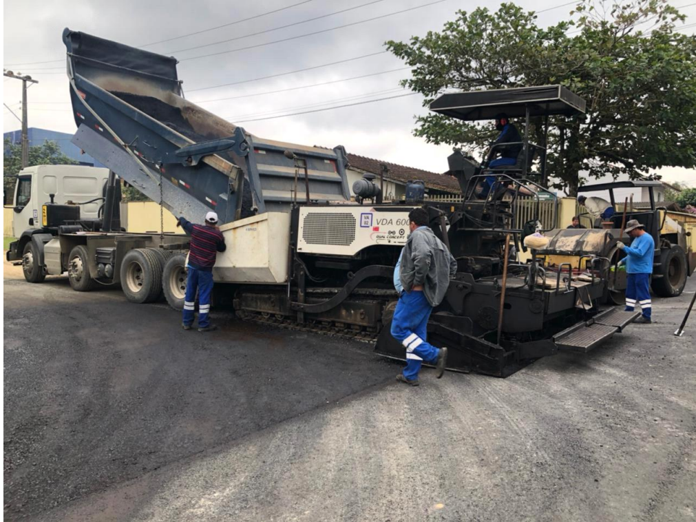
Figura 99 - Pavimentação asfáltica
