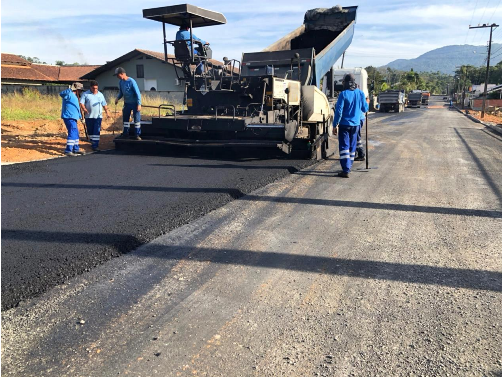
Figura 73 - Pavimentação asfáltica
