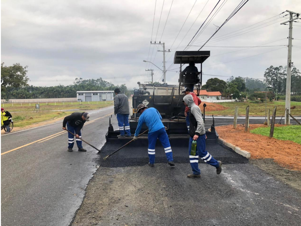
Figura 84 - Pavimentação asfáltica
