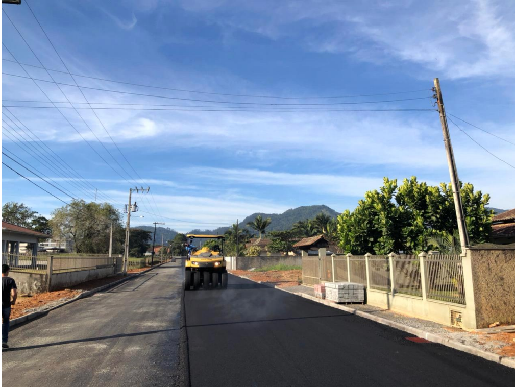
Figura 71 - Pavimentação asfáltica
