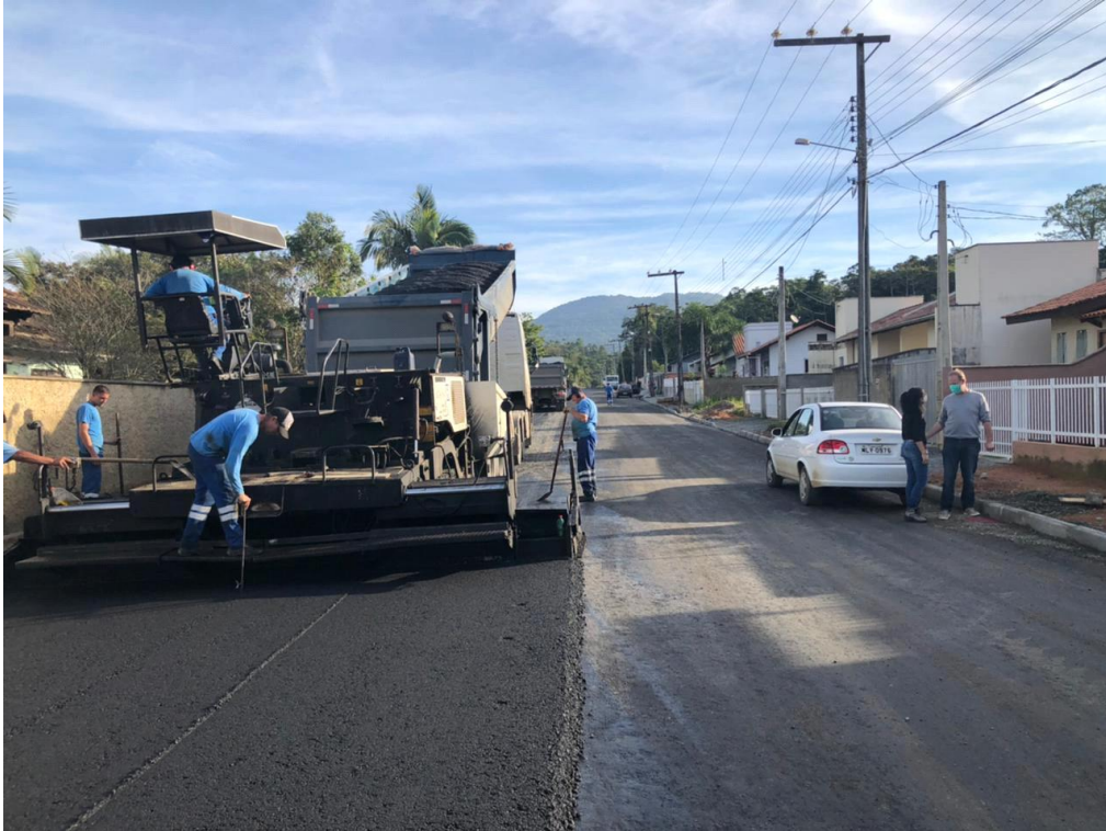
Figura 77 - Pavimentação asfáltica
