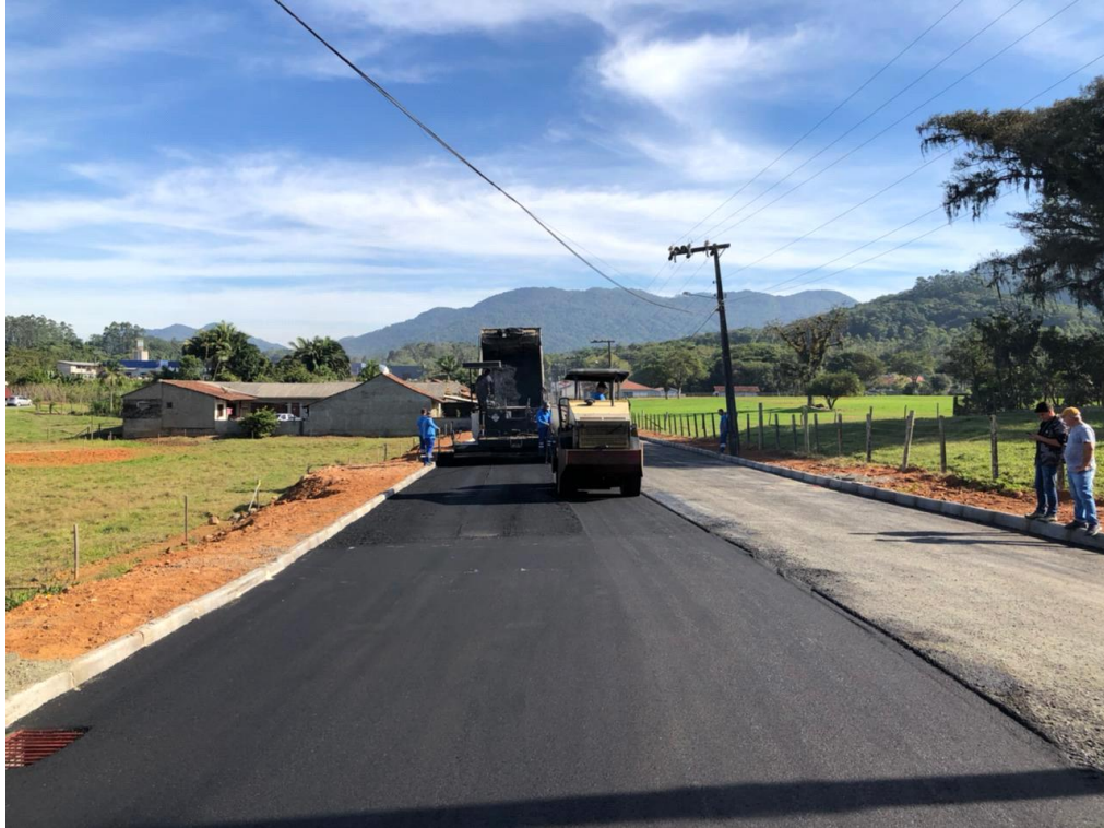
Figura 63 - Pavimentação asfáltica
