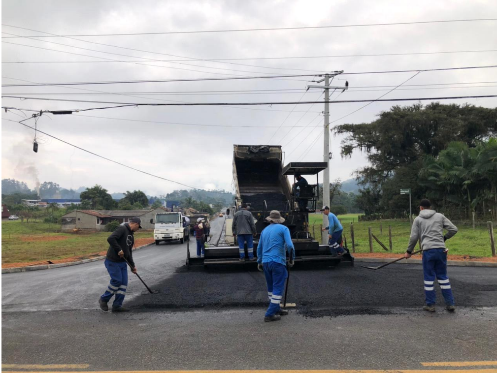
Figura 60 - Pavimentação asfáltica
