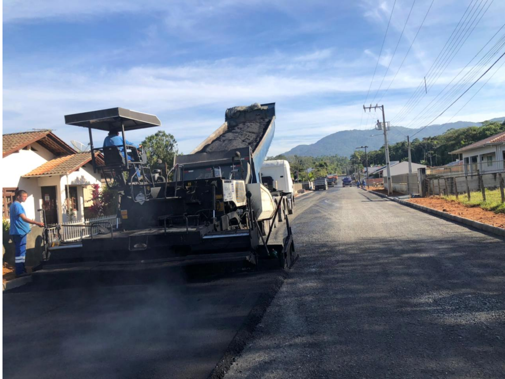
Figura 75 - Pavimentação asfáltica
