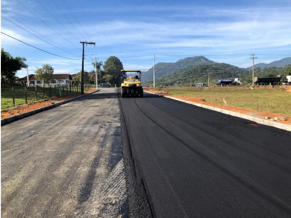
Figura 65 - Pavimentação asfáltica
