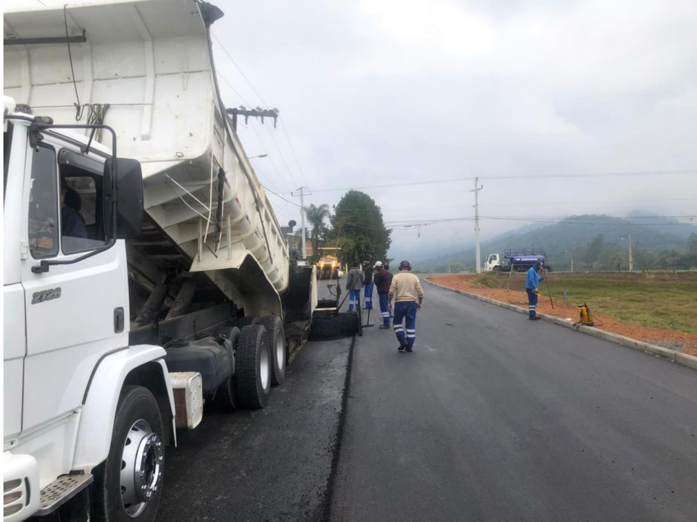
Figura 89 - Pavimentação asfáltica
