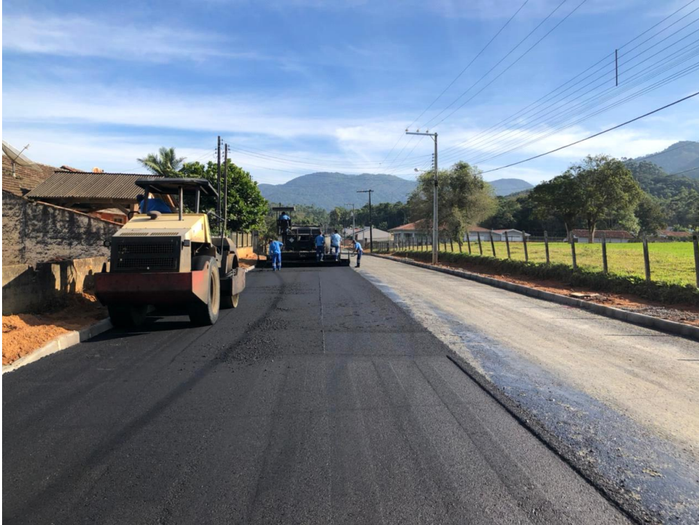
Figura 70 - Pavimentação asfáltica
