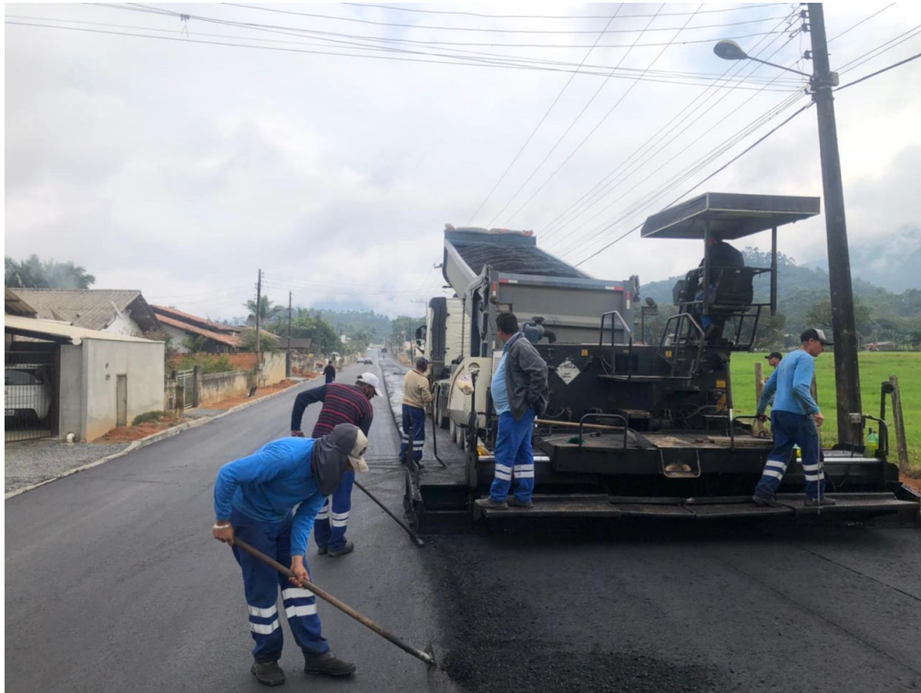
Figura 88 - Pavimentação asfáltica
