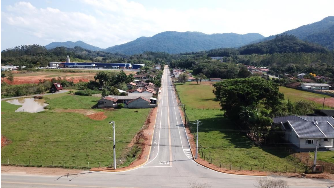
Figura 108 - Vista obra concluída
