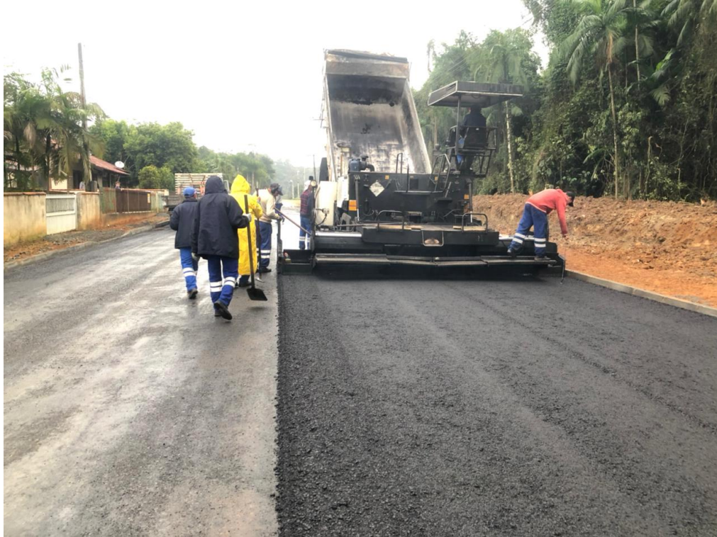
Figura 107 - Pavimentação asfáltica
