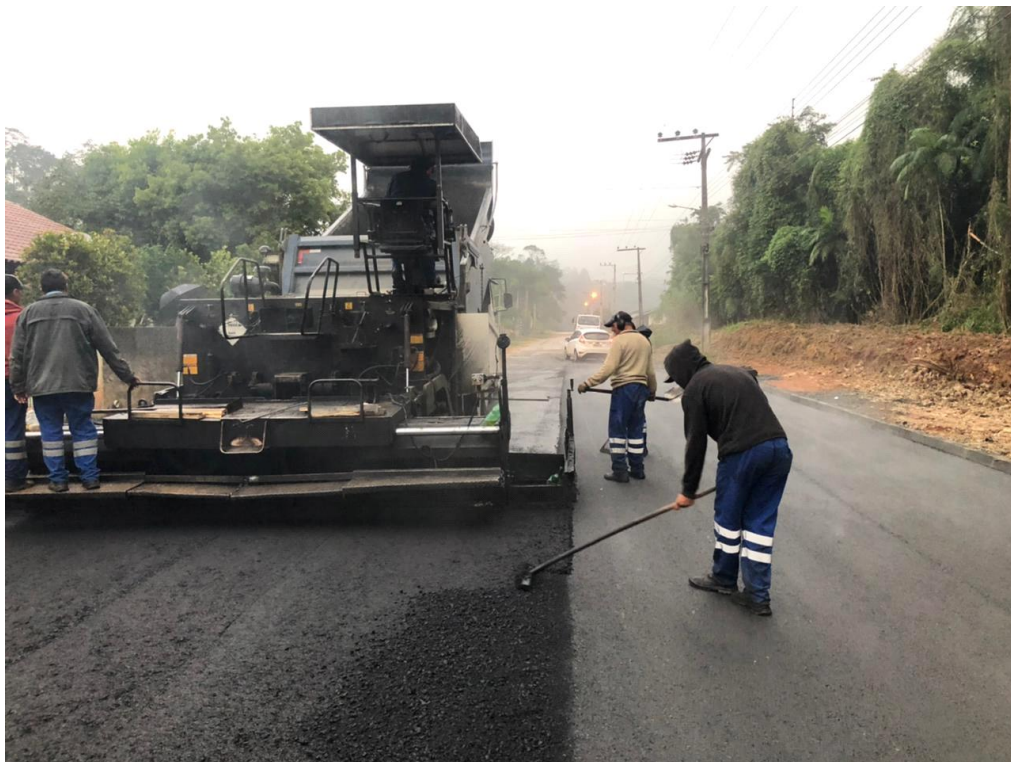
Figura 100 - Pavimentação asfáltica
