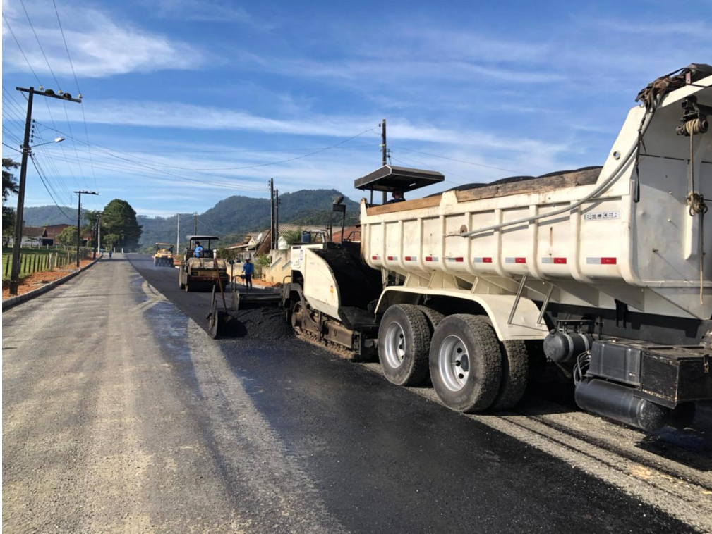
Figura 62 - Pavimentação asfáltica
