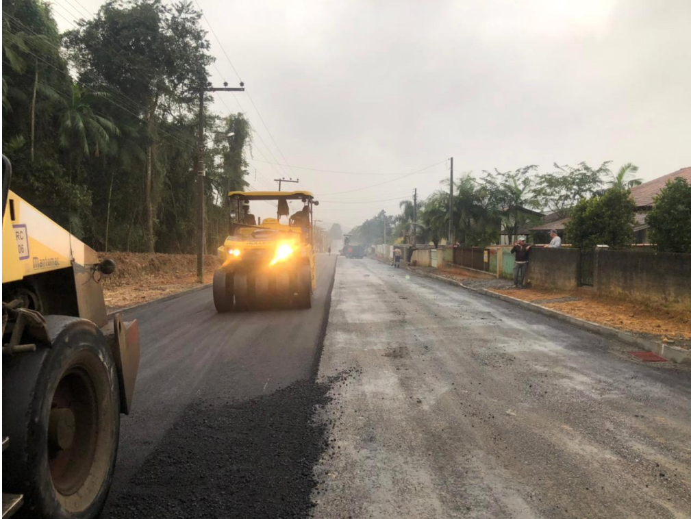
Figura 104 - Pavimentação asfáltica
