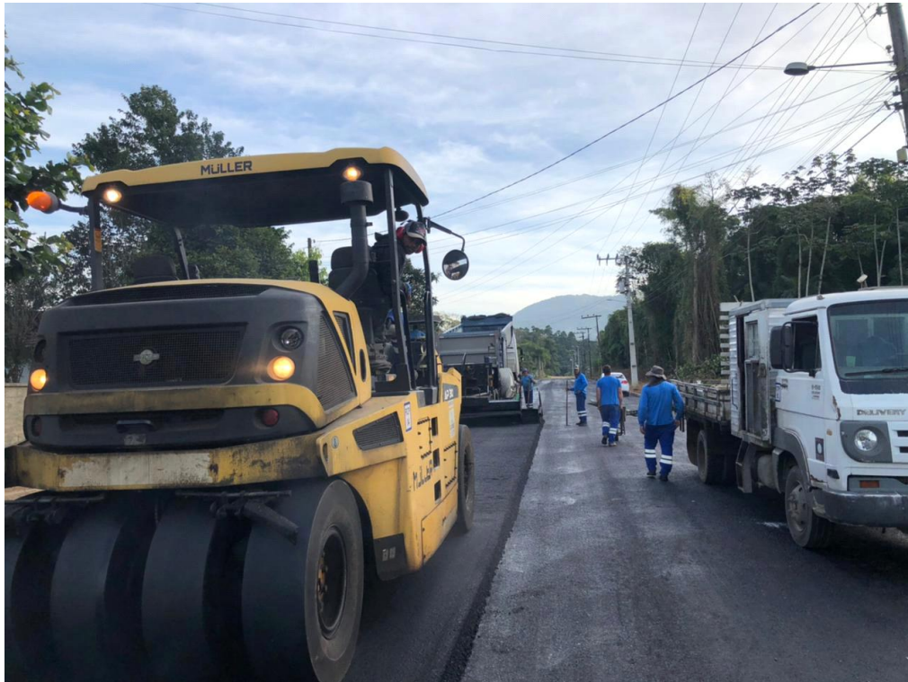
Figura 83 - Pavimentação asfáltica
