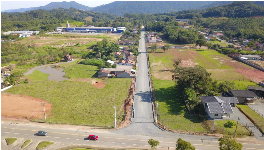
Figura 1 - Vista do Local
