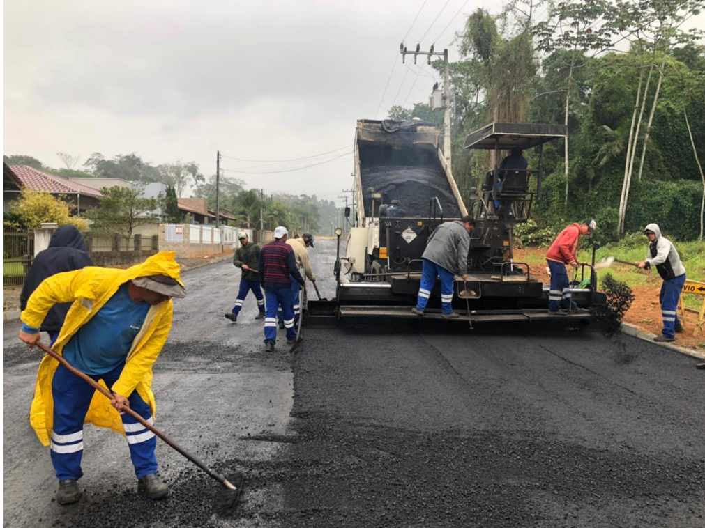
Figura 94 - Pavimentação asfáltica
