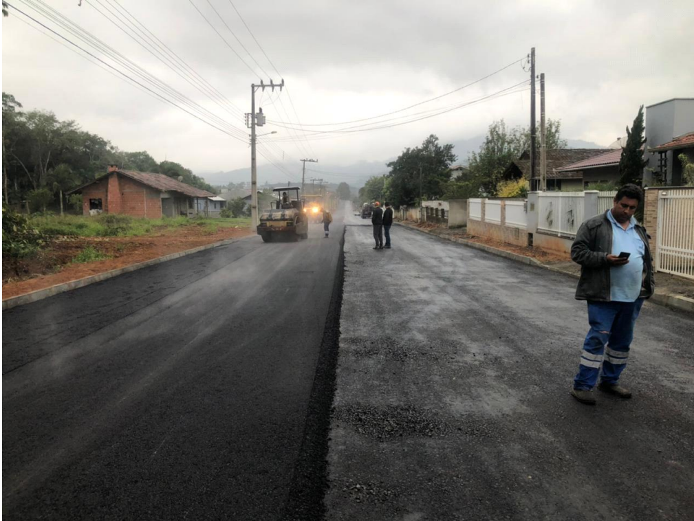
Figura 92 - Pavimentação asfáltica
