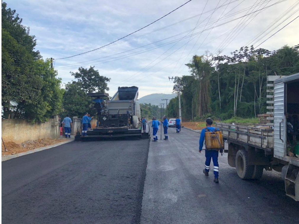
Figura 82 - Pavimentação asfáltica
