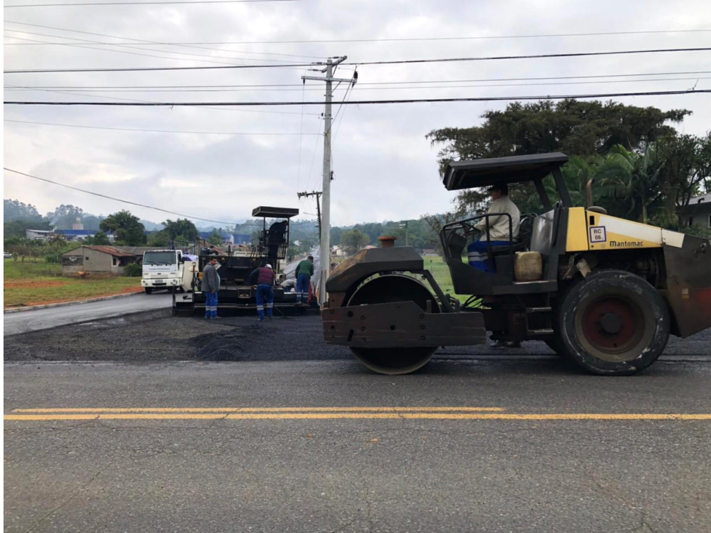
Figura 86 - Pavimentação asfáltica
