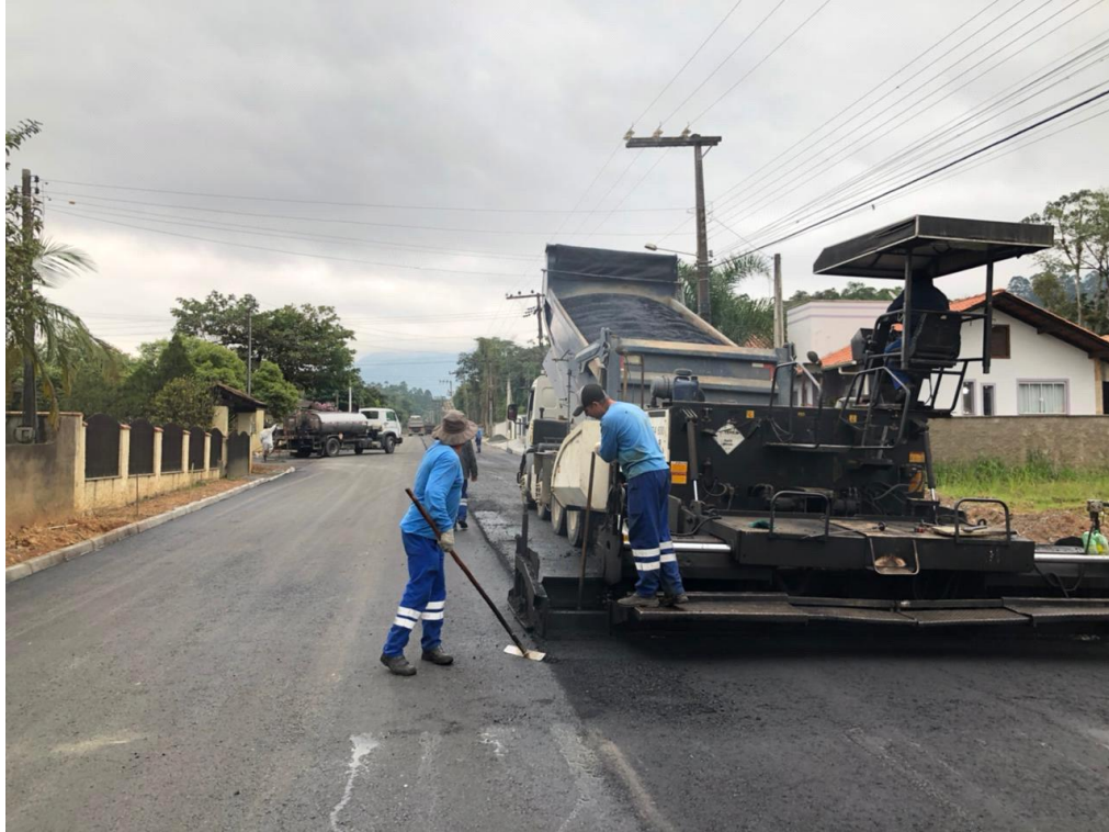
Figura 100 - Pavimentação asfáltica
