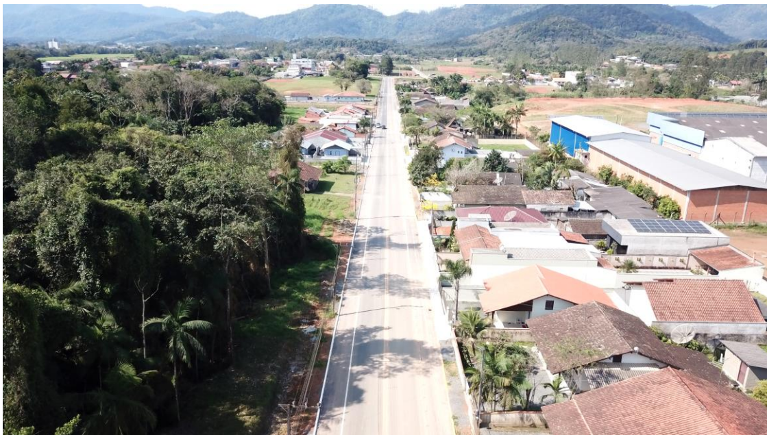
Figura 109 - Vista obra concluída
