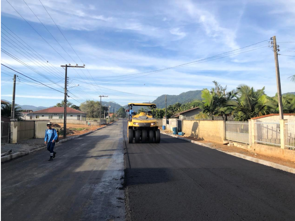
Figura 80 - Pavimentação asfáltica
