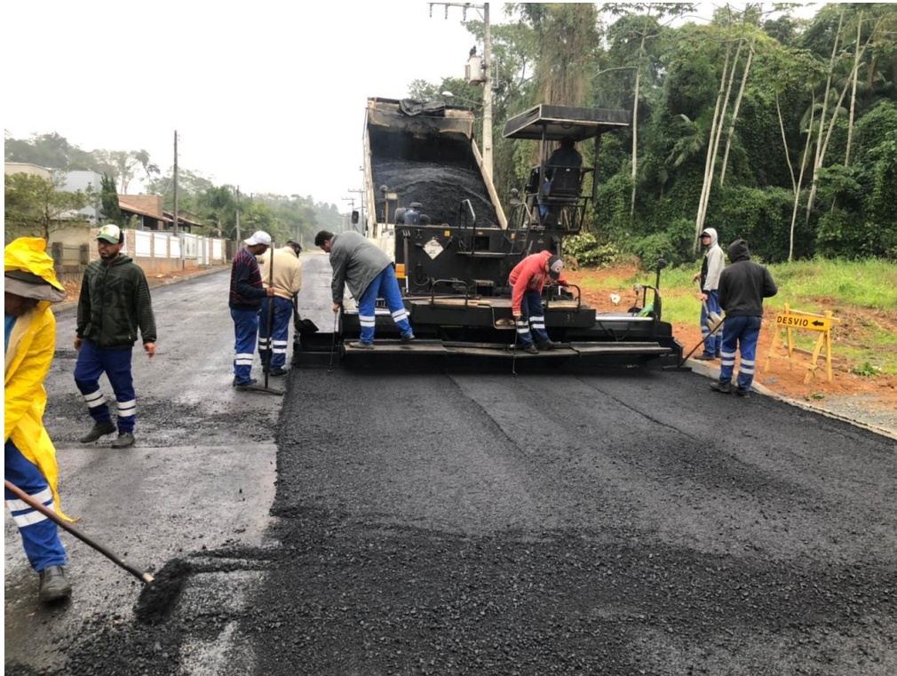
Figura 93 - Pavimentação asfáltica
