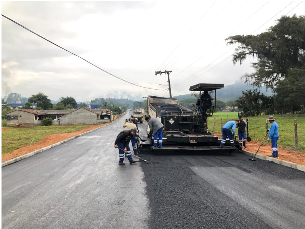
Figura 91 - Pavimentação asfáltica
