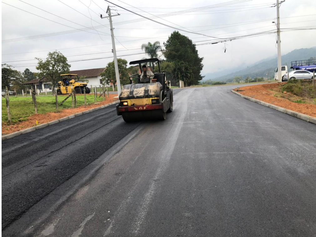
Figura 90 - Pavimentação asfáltica
