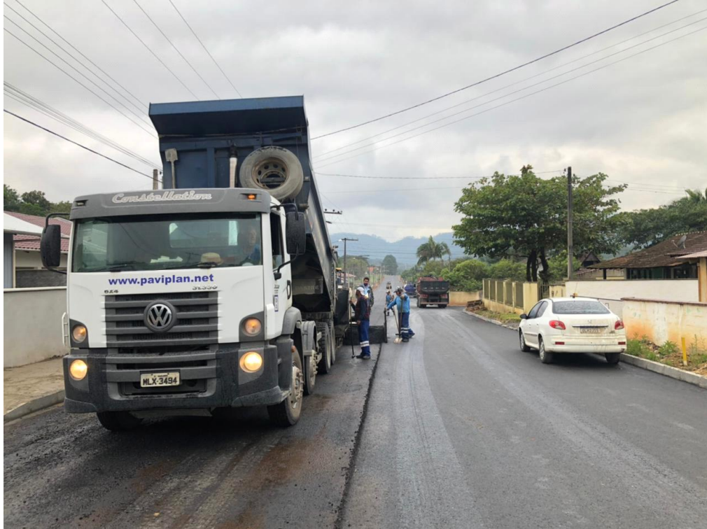
Figura 96 - Pavimentação asfáltica
