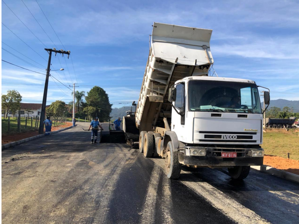
Figura 64 - Pavimentação asfáltica
