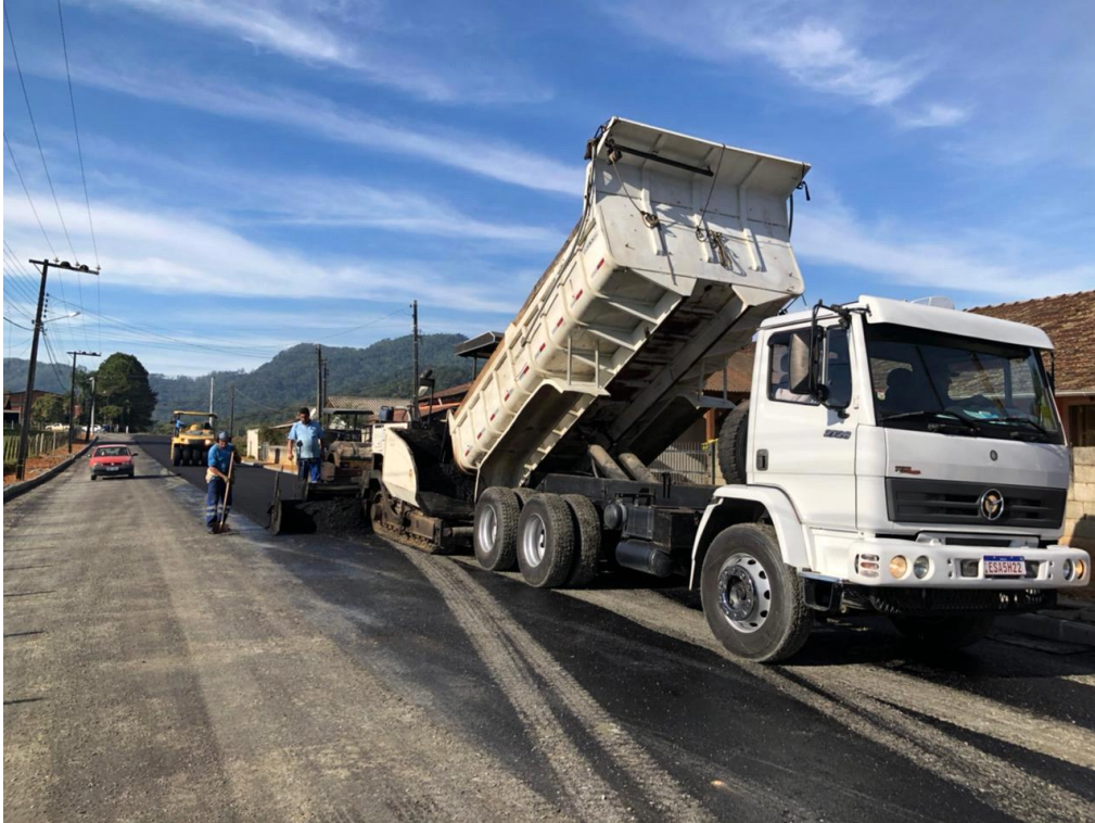
Figura 68 - Pavimentação asfáltica
