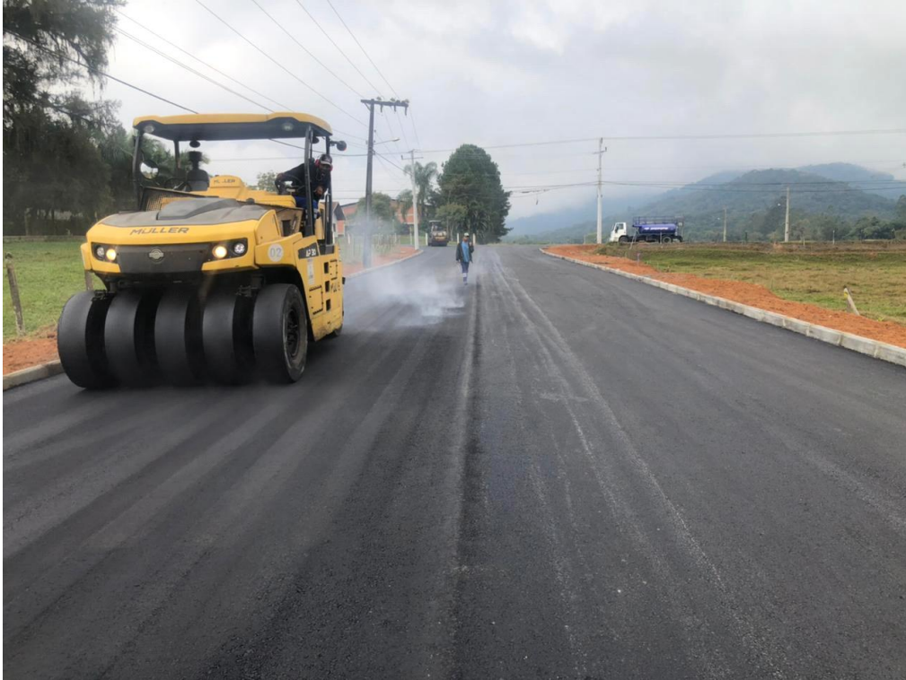
Figura 103 - Pavimentação asfáltica
