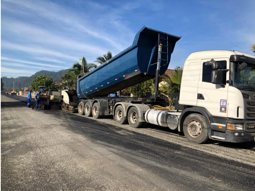
Figura 74 - Pavimentação asfáltica
